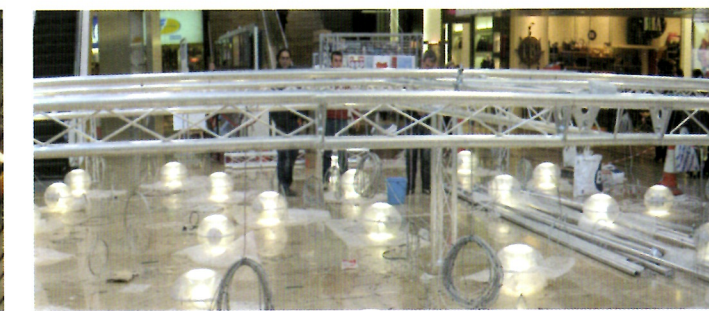
Montaje estructura telaraña
